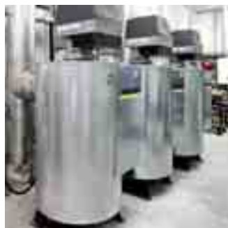
Запатентованные прямоточные водонагреватели.
